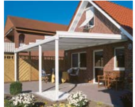
WGM Sottezza under patio roof
